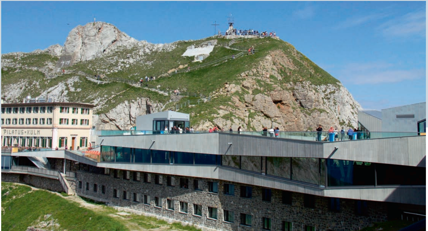
Südseite der Panoramagalerie: Die polygonalen, hochisolierten Verglasungen weisen keinen einzigen rechten Winkel auf. Côté sud de la galerie panoramique : les vitrages polygonaux ultra-isolés ne comportent pas un seul angle droit.
