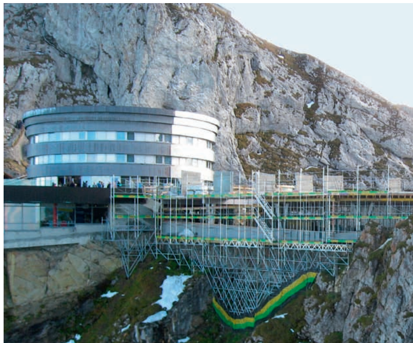
Die Topografie des Geländes forderte auch die Gerüstbauer. La topographie du terrain a aussi constitué un défi pour les constructeurs d'échafaudages.
